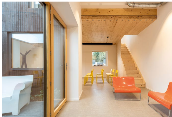
LES LOGES, Laval (53) - Planchers CLT HEXAKIT- Architecte : M. Vincent HEMERY - IE ARCHITECTURE - © Simon Guesdon
