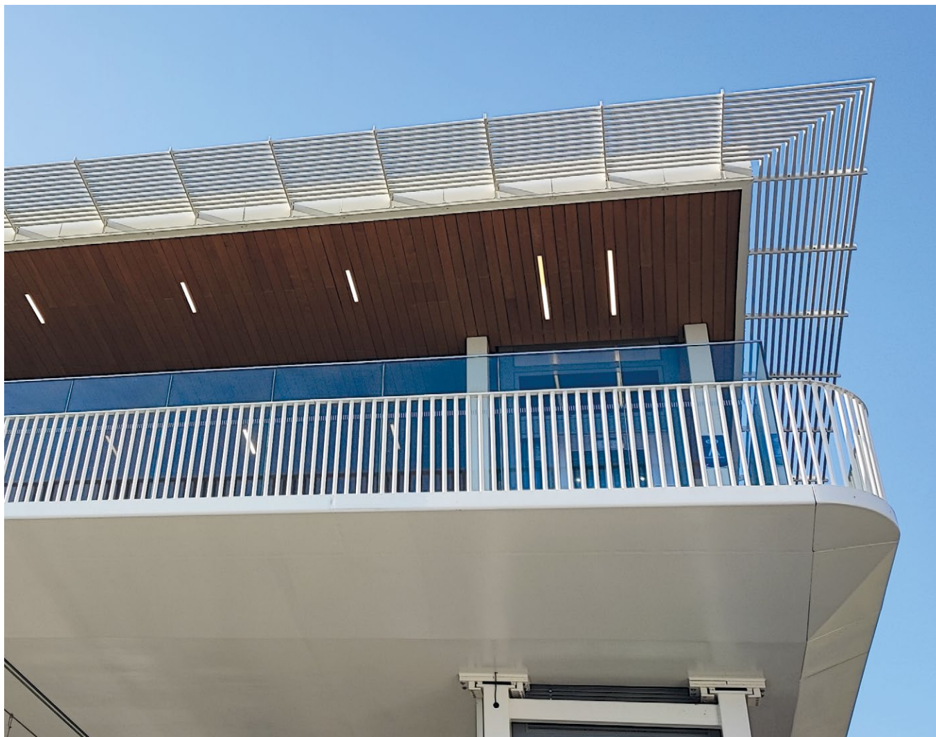
Gare de Pau, aménagement bois de robinier, protégé au saturateur SI106 teinte teck, gamme Owatrol® Industrie
