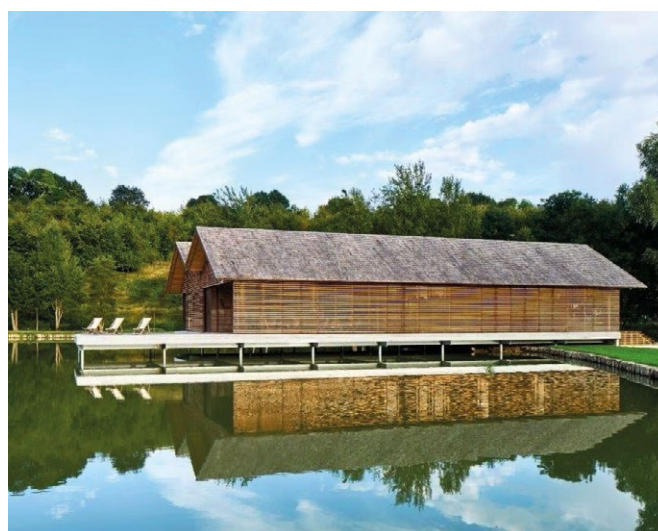
SALLE DE RÉCEPTION SUR TECHNO PIEUX
