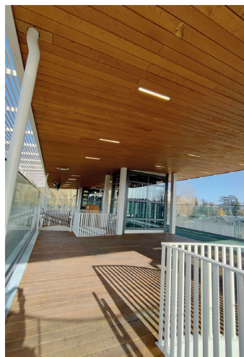
Gare de Pau, aménagement bois de robinier, protégé au saturateur SI106 teinte teck, gamme Owatrol® Industrie
