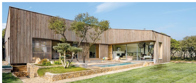
Bardage LEGATO en Douglas avec imprégnation pré-grisé | Architectes : Marie Orssaud | ©POMELO STUDIO
