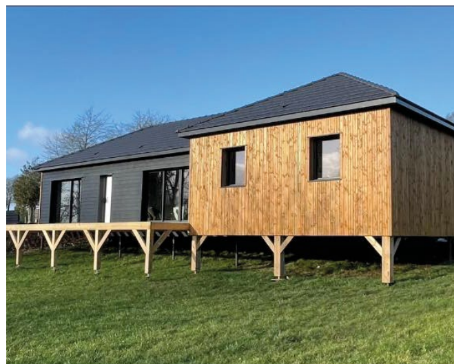
AGRANDISSEMENT SUR TECHNO PIEUX
