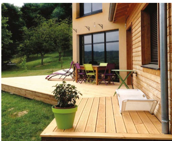
TERRASSE SUR TECHNO PIEUX
