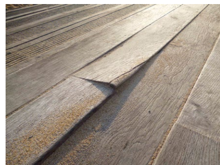
Lame bois autoclavé sans protection présentant une gerce en cours de formation due à l'humidité et une pose mal adaptée
