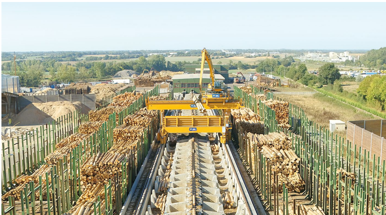
Parc à grumes sur le site de transformation La Gauvrie - PIVETEAU à Sainte-Florence (85) | © PIVETEAUBOIS
