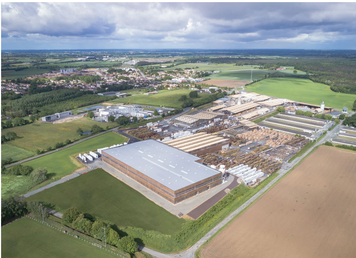
Site de production de deuxième transformation, Les Hauteurs - PIVETEAU à Sainte-Florence (85) | © PIVETEAUBOIS
