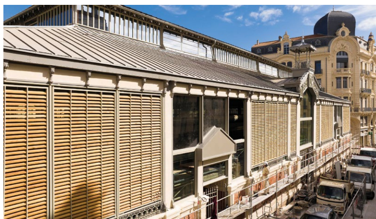
© Ville de Béziers- Chantier des Halles, Architecte NAOS, Maîtrise d'ouvrage Groupe Chevreul
