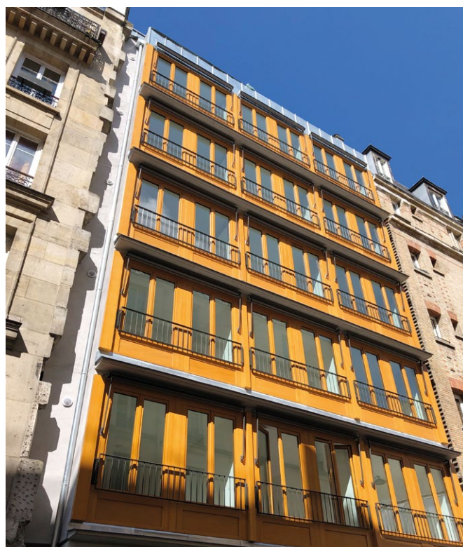
Rue Philippe de Girard, l'architecte Paolo Tarabusi ose la façade menuisée avec Bieber.
